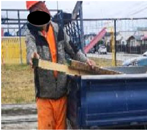
Se observa la carga de tablonés desde el camión, para lo cual debe jalarlos con fuerza, ambas manos en agarre y codos extendidos. Sin uso de guantes.
