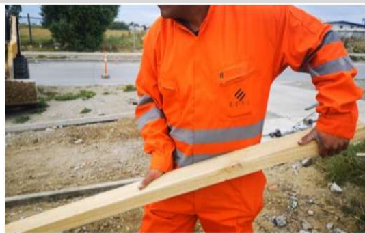
Se observa uso de niveladora manual de madera, la cual pasa por la superficie del material para emparejarlo. La toma con ambas manos en agarre, con flexión de muñeca y movimientos de flexoextensión de codos, en rango y frecuencia variable. Sin uso de guantes.
