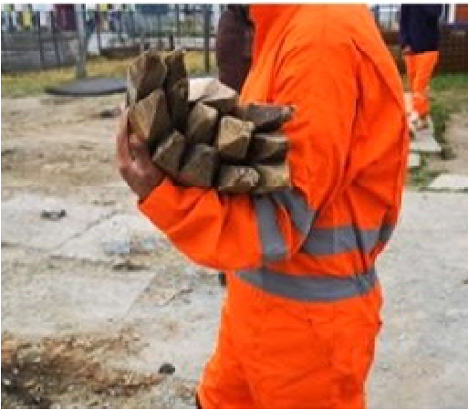
Se observa el transporte de las estacas de madera, con supinación de ambos antebrazos y flexión de ambos codos en 90° desde el camión hasta el lugar de acopio. Sin uso de guantes.
