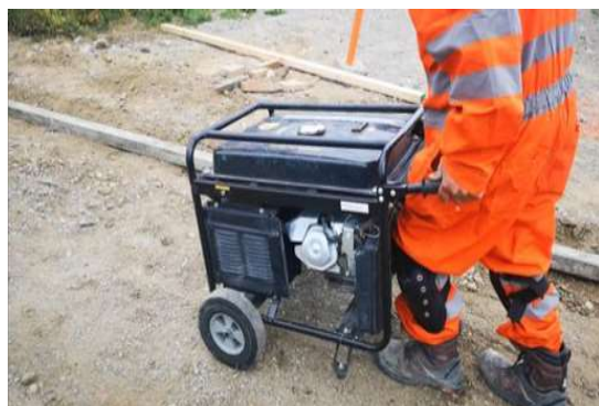
** No estaba la máquina apisonadora en el momento de la visita, por lo cual se simuló el agarre con un generador. Se observa uso de placa apisonadora para compactar el material, debiendo empujarla por todo el terreno. Agarre con ambas manos, fuerza de empuje, codos en postura mantenida de 60° aproximadamente. Sin uso de guantes.
