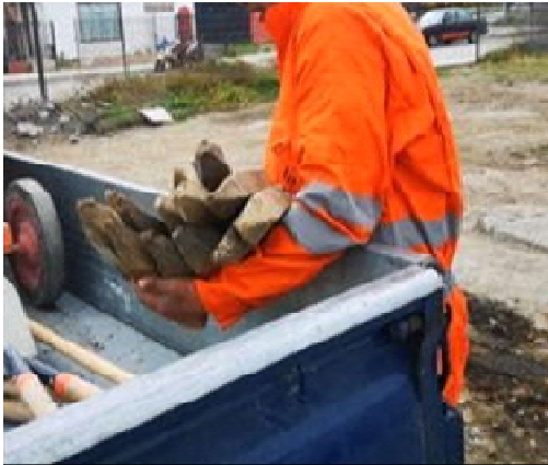
Se observa la carga de estacas de madera, con supinación de antebrazo izquierdo y flexión de ambos codos en 90° durante el transporte desde el camión hasta el lugar de acopio. Sin uso de guantes.
