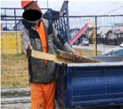
Se observa la carga de tablones desde el camión, para lo cual debe jalarlos con fuerza, ambas manos en agarre y codos extendidos. Sin uso de guantes.
