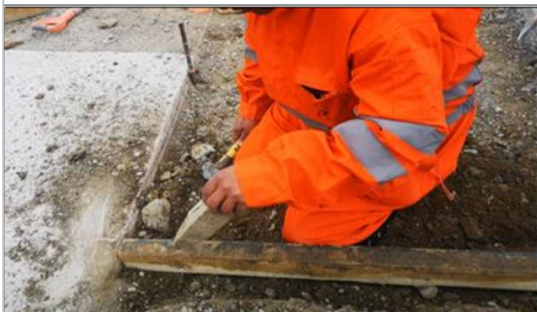
Se observa operación de fijar los moldajes con estaca de madera. Toma la estaca con la mano izquierda, sin uso de fuerza, postura neutra de muñeca, en el punto donde debe colocarla. Sin uso de guantes.
