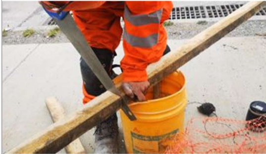
Se observa corte de molduras con serrucho. Sujeta la madera con mano izquierda en extensión y agarre con fuerza y corta con serrucho que manipula con la mano derecha. El serrucho se atasca al cortar, según indica el trabajador, porque la herramienta está muy gastada.
