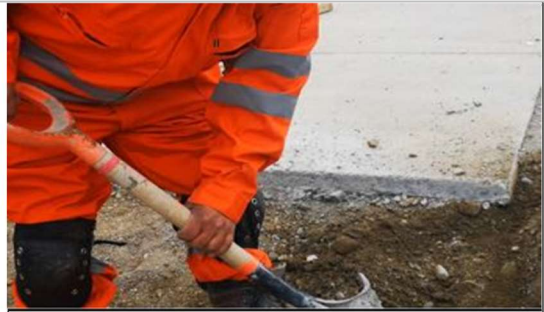
Se observa uso de pala para retiro de material suelto con picota. La toma con ambas manos en agarre con fuerza, muñecas con leve extensión, y movimientos de flexión de codos principalmente. Sin uso de guantes.
