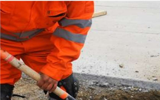
Se observa operación donde esparce material con pala. Toma la herramienta con ambas manos en agarre, realiza movimientos de flexoextensión de codos y pronosupinación, en rangos variables. Sin uso de guantes.
