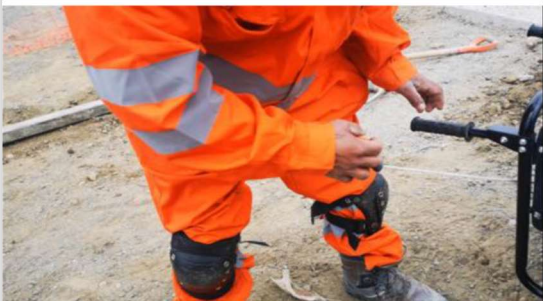
Finalmente el paciente compacta el material con máquina apisonadora, con agarre con fuerza de ambas manos. La máquina pesa 40 kilos, y funciona a motor diesel. Dado que cuando funciona vibra, el agarre se ve dificultado y requiere emplear más fuerza.
