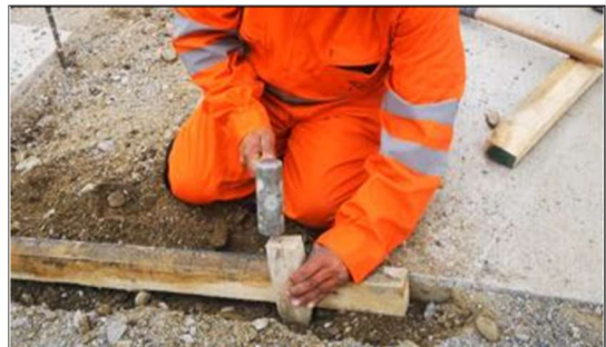
Continuación de lo anterior, golpea la estaca con combo que manipula con la mano derecha, mano izquierda sujeta la estaca con postura neutra de muñeca y fuerza leve. Sin uso de guantes.
