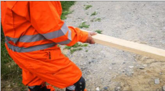
Posteriormente el trabajador nivela el material de relleno, con una apisonadora manual de madera. Toma la apisonadora manual con agarre con fuerza y la acerca hacia su cuerpo para ir nivelando la superficie, y posteriormente la aleja de su cuerpo.
