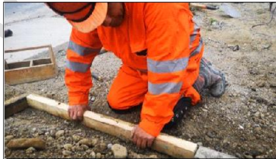
Se observa operación de colocar moldajes previamente cortados. Agarre con ambas manos, fuerza leve y postura de ambas muñecas en extensión. Sin uso de guantes.
