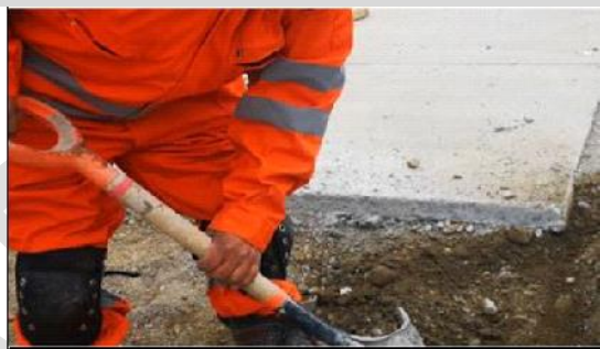
Se observa uso de pala para retiro de material al suelo con picota. La toma con ambas manos en agarre con fuerza, muñecas con leve extensión, y movimientos de flexión de codos principalmente. Sin uso de guantes.
