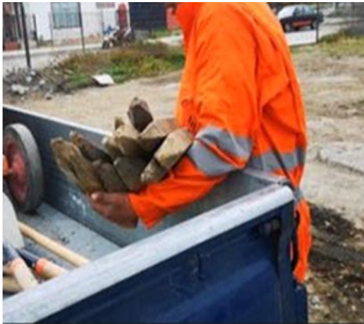
Se observa la carga de estacas de madera, con supinación de antebrazo izquierdo y flexión de ambos codos en 90° durante el transporte desde el camión hasta el lugar de acopio. Sin uso de guantes.
