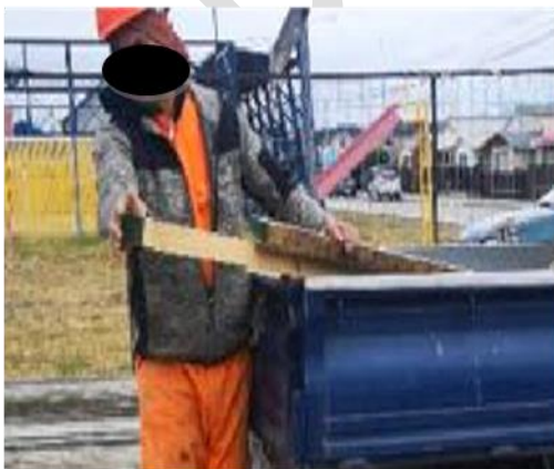
Se observa la carga de tablones desde el camión, para lo cual debe jalarlos con fuerza, ambas manos en agarre y codos extendidos. Sin uso de guantes.
