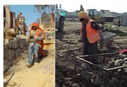
Jornal de Excavación
