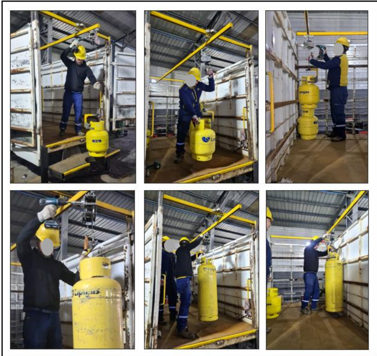
Foto 14: Traslación de Cilindros en interior de Camión.
