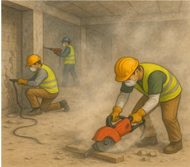
Imagen 3. Hombres trabajando en construcción con exposición a polvo de sílice
