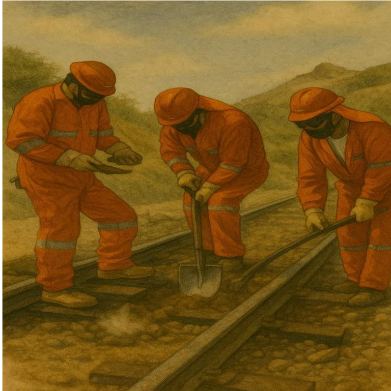
Imagen 6. Trabajadores realizando mantenimiento en vías férreas
